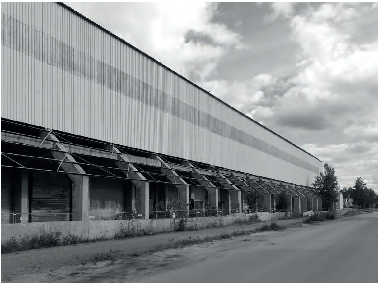
Varastorakennus ennen purkua.
